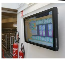
题,监控系统将发出警报,"Stéphane Fournier说。智能化。我们在一个地方就能监控温度控制的每个环节。"现在Jendryka先生可以通过他的个人电脑监控所有酒罐。"PcVue监控系统使我们的发酵窖在这一正面经验的鼓舞下,凯歌的技术团队很快意识到如何将PcVue用于其它地方。它不仅能监控酒罐中葡萄酒的发酵,还能监控最终混合后的冷稳定阶段的制冷过程。
